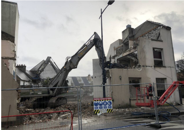
Rue de la Gare, l'ancienne clinique est démolie
