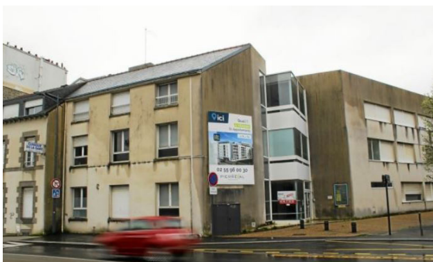
L'ancienne clinique, située au 27, rue de la Gare à Saint-Brieuc, laissera bientôt la place à une résidence de 61 logements. (Le Télégramme/Julien Molla)
