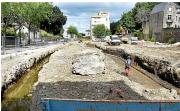
À gauche, le nouveau tracé du Frouit, le temps des travaux de fondation du projet immobilier. À droite, son ancien et futur tracé, qui sera consolidé avec des ponts béton avant d'être recouvert par la chape.
