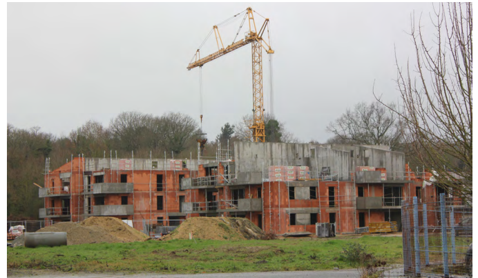
Deux immeubles de deux étages (R + 2) accueilleront 30 logements sociaux.
