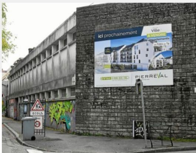
L'ancienne école Saint-Corentin va être rasée pour laisser place à 87 appartements, dont 54 dédiés au logement social. (Le Télégramme/Jacky Hamard)
