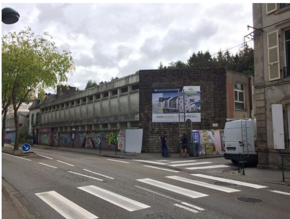
Le promoteur Pierreval a repris l'ancienne école Saint-Corentin pour y construire 76 logements. (©Côté Quimper)
