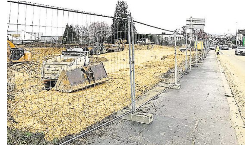
Un bunker allemand avait été mis au jour lors d'un chantier près du centre de Caen, l'an passé. Il a été recouvert de terre, début mars, un an après.
