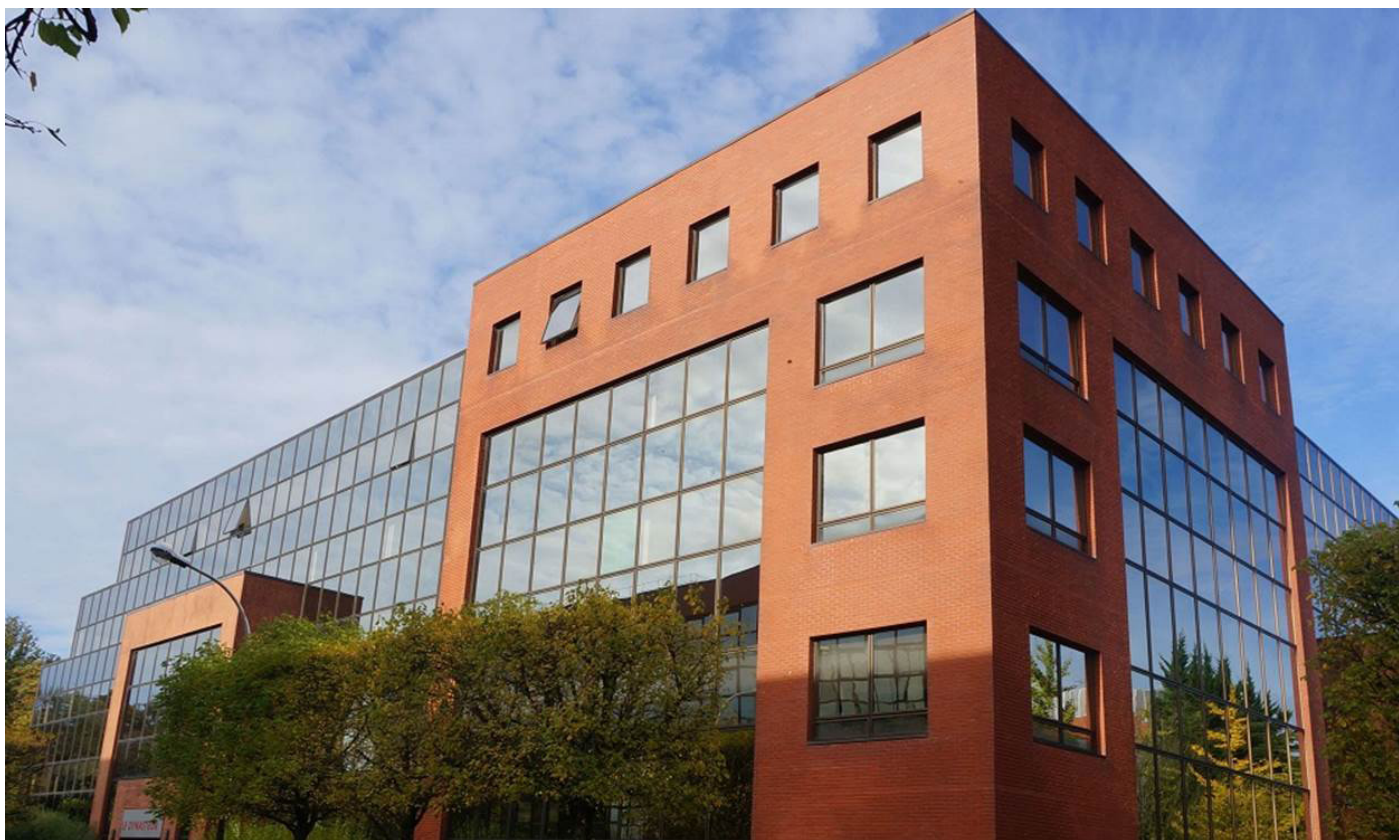
Immeuble Le Dynasteur, à Meudon (92) © Alex Bolton Partners
